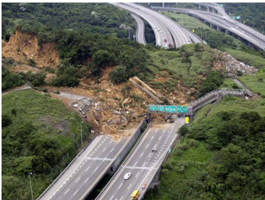
Рисунок 5.3 – Разрушительный оползень на Тайване. Участок Национального шоссе длиной в 300 метров погребен под тоннами земли и грязи. (Soil and Water Conservation Bureau, SWCB).
