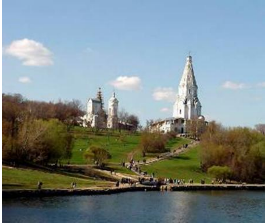
Рисунок 6.19а – Музей-заповедник Коломенское. Общий вид. Оползневой склон (фото Сваловой В.Б.)
