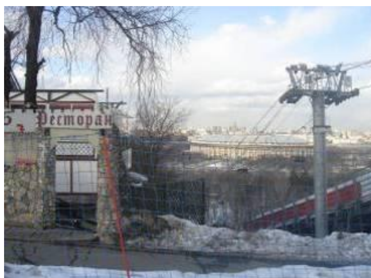
Рисунок 6.17 б – Участки активизация оползневых процессов около трамплина на Воробьевых горах. 2007 г. (Фото Сваловой В.Б.)
