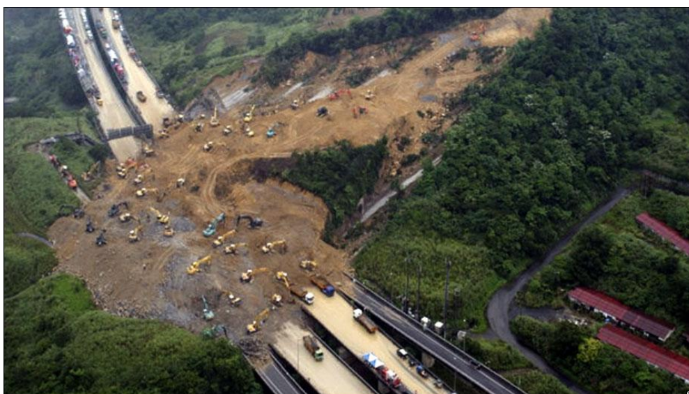
Рисунок 5.2 – Оползень на Тайване вследствие дождей в 2010 г. (Soil and Water Conservation Bureau, SWCB).
