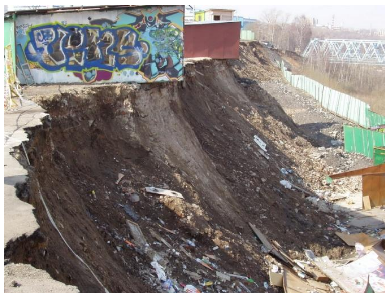
Рисунок 6.26 – Активизация оползневой процесса в районе Москворечье в сентябре 2009 г. (Фото ФГУП «Геоцентр-Москва»)
